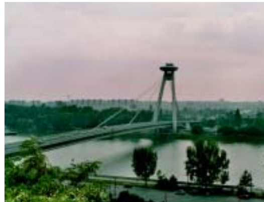
Donaubrücke in Bratislava.
