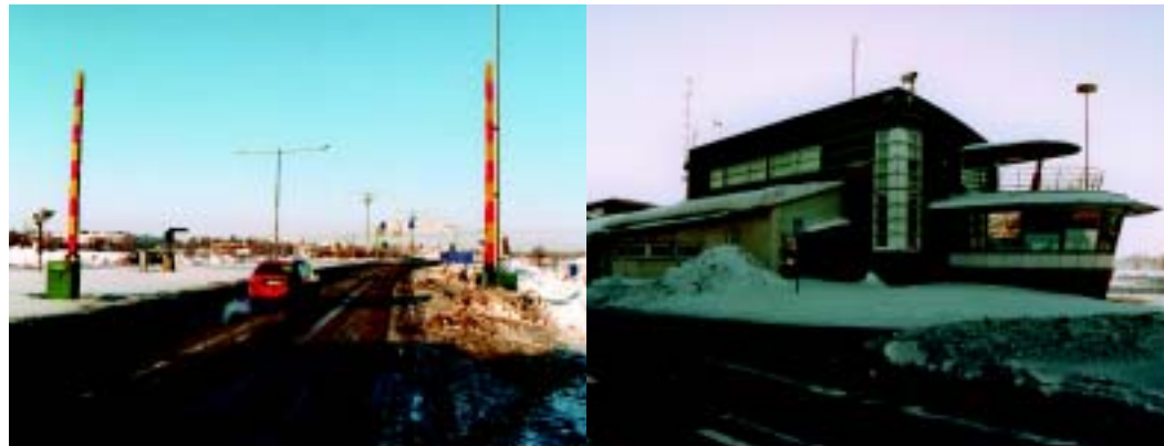
Links: Offene Grenze zwischen Tornio (Finnland) und Haparanda (Schweden). Rechts: Ehemalige Zoll- und Passkontrollstelle.
