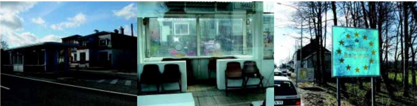
Offener Grenzübergang zwischen Deutschland und Belgien bei Aachen. Links und Mitte: Leerstehende Gebäude der ehemaligen Zoll- und der Passkontrolle.
